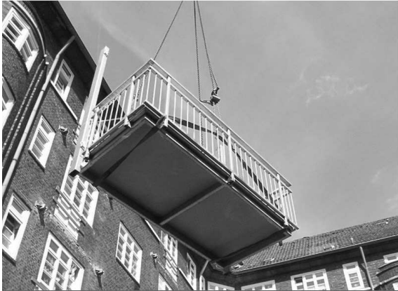
Das vormontierte Balkonelement wird mittels Kran transportiert.
