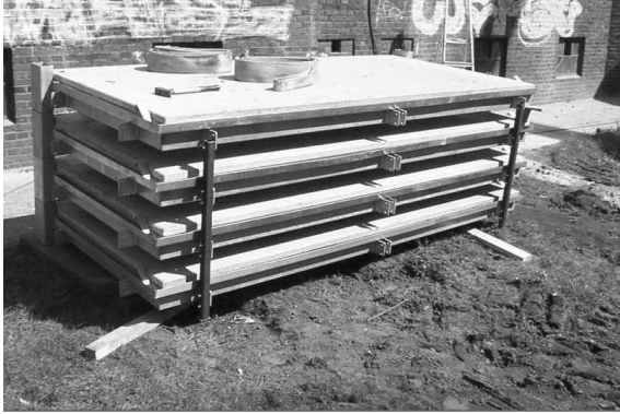
Vormontierte Balkonplatten auf verzinktem Stahlrahmen.
