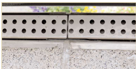
Edelstahlrinne ist durch eingeklebtetes Verbindungselement verbunden.
