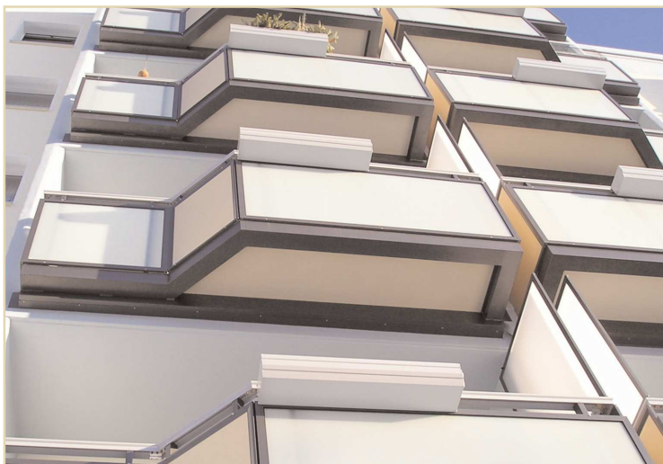
Anwendungsbeispiele für Loggienerweiterungen mit Mineralit - Balkonplatten
