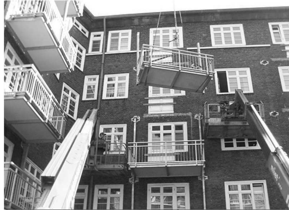
Das Balkonelement wird an die vorbereitete Wandverankerung montiert.
