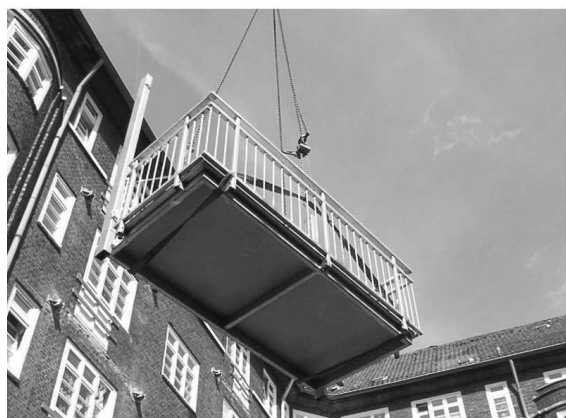
Das vormontierte Balkonelement wird mittels Kran transportiert.
