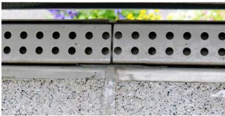
Edelstahlrinne ist durch eingeklebtetes Verbindungselement verbunden.
