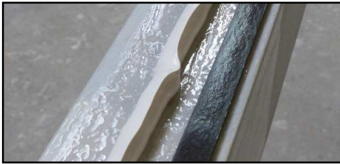
Skizzen Unterkonstruktion mit Montageband und Kleber, Ansicht von oben (Beispiel)
