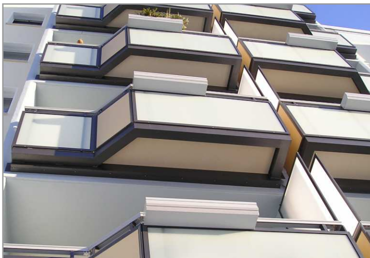
Anwendungsbeispiele für Loggienerweiterungen mit mineralit®- Balkonplatten
