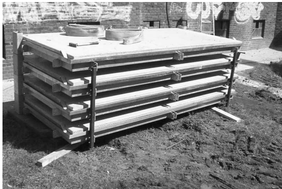
Vormontierte Balkonplatten auf verzinktem Stahlrahmen
