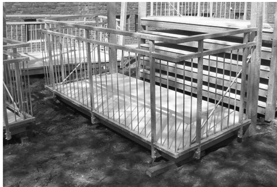
Geländer und Wandbefestigung sind montiert – das so vorgefertigte Balkonelement kann an die Wand gebracht werden.
