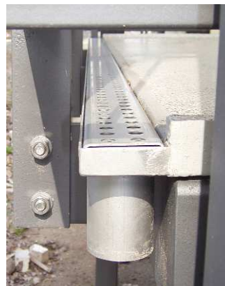
links: mineralit® Balkonbodenplatte mit stirnseitiger Regenrinne
