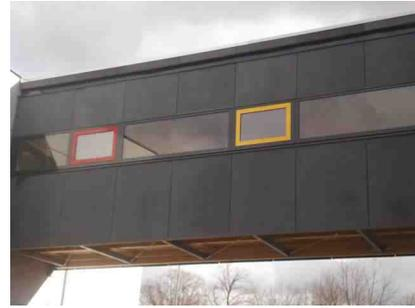
Schwarze Fassade, großflächige Elemente; Befestigung: genietet;
