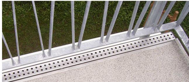
Integrierte Entwässerungsrinne an der Außenseite des Balkons
