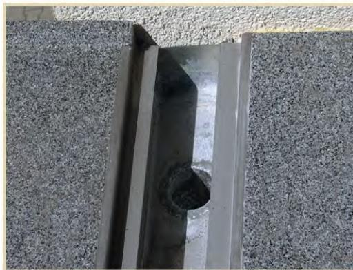
Neben der Auswahl an verschiedenen Farbdekoren, Plattenstärken & Plattengrößen **kann die Rinne nahezu an jeder Stelle der Platte angegossen werden.** So kann eine hausseitige Einbindung ans Fallrohr oder eine seitlich angebrachte Rinne individuell realisiert werden.
