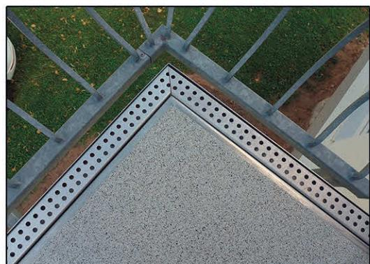
Die Mineralit Balkonbodenplatten werden individuell nach Aufmaß hergestellt und bereits montagefertig ausgeliefert, wobei die Plattenelemente **nach dem Einbau sofort begehbar** sind. Alle Verarbeitungsmaterialien und Anleitungen zur fachgerechten Montage können natürlich mit geliefert werden.
