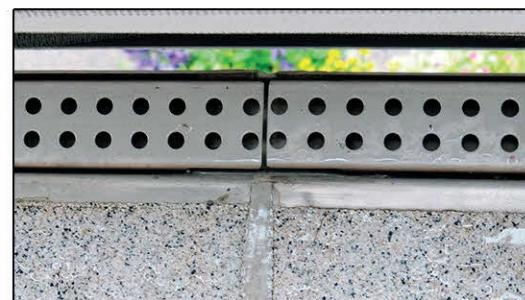
Die angegossene Edelstahl (V2A) Entwässerungsrinne kann sowohl stiern- als auch wandseitig oder seitlich, je nach Bauvorhaben individuell, ausgeführt werden. Selbstverständlich ist die Rinne an den Seitenenden geschlossen, sofern diese nicht bei geteilten Balkonplatten mit Verbindungselementen zusammengefügt oder mit Winkelstücken mehrseitig gefertigt werden soll.
