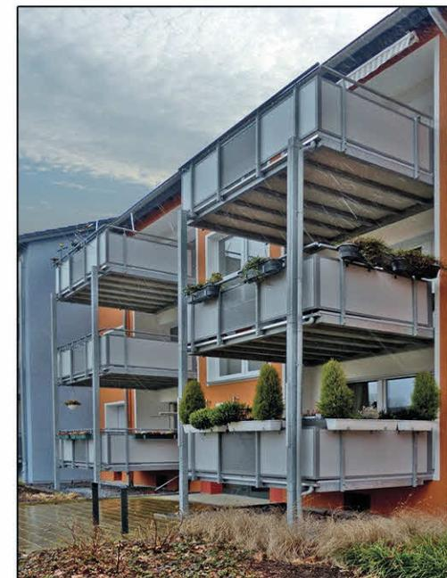
**Zeitgewinn und Kostensparnis durch einfache Unterkonstruktion, schnelle Montage und minimalen Personalaufwand bei maximaler Anwendungsdauer.** Die freitragenden Mineralit - Balkonbodenplatten bestehen aus Polymerbeton (94% natürlicher Quarzsand, gebunden mit einem Acrylharz). Die Materialqualität ist dabei mit einem hochwertigem **Naturstein (z.B. Granit) vergleichbar**, der bei einer hohen Tragfähigkeit und nachgewiesenen Langlebigkeit auch filigrane Balkonkonstruktionen ermöglicht.
