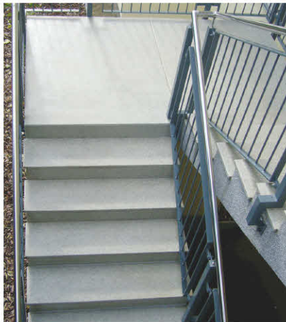
Mit Mineralit - sanierte Treppenanlage mit Podest – Draufsicht und Seitenansicht
