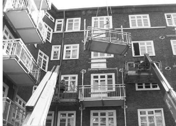
Das Balkonelement wird an die vorbereitete Wandverankerung montiert.
