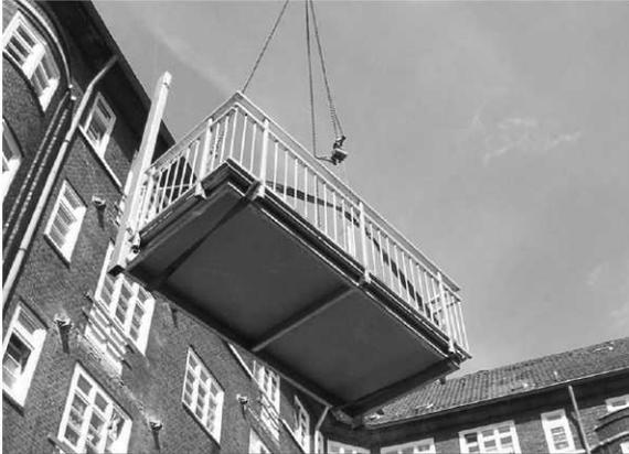
Das vormontierte Balkonelement wird mittels Kran transportiert.
