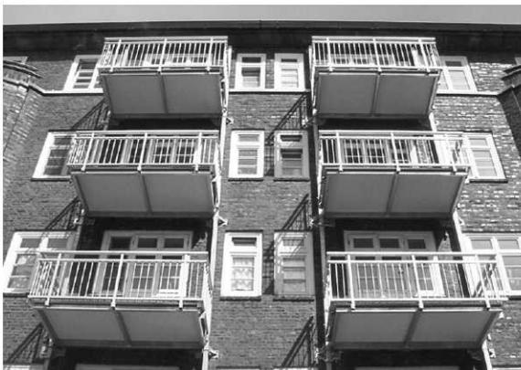
Zwei fertig gestellte Türme – die Balkonplatte aus Mineralit als leichte und dauerbeständige Balkongrundplatte.
