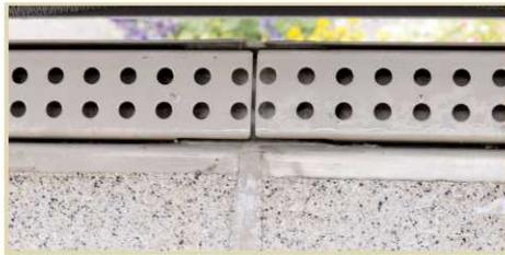
Edelstahlrinne ist durch eingeklebtes Verbindungselement verbunden.
