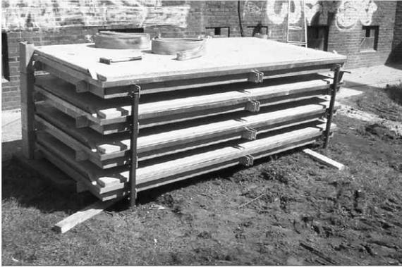
Vormontierte Balkonplatten auf verzinktem Stahlrahmen.
