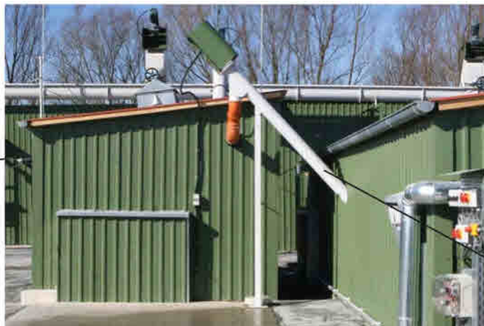
Verbindung zwischen Impfkulturtank und Mischbehälter für die portionsweise Zufuhr von Substratmus
