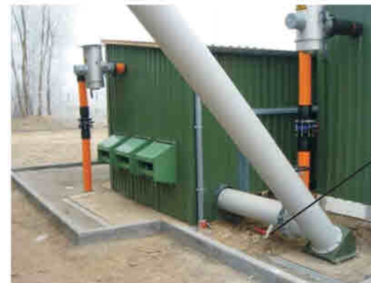
Probenentnahme Austragsschnecke des Mischbehälters; Gasableitungen von Mischbehälter und Impfkulturtank
