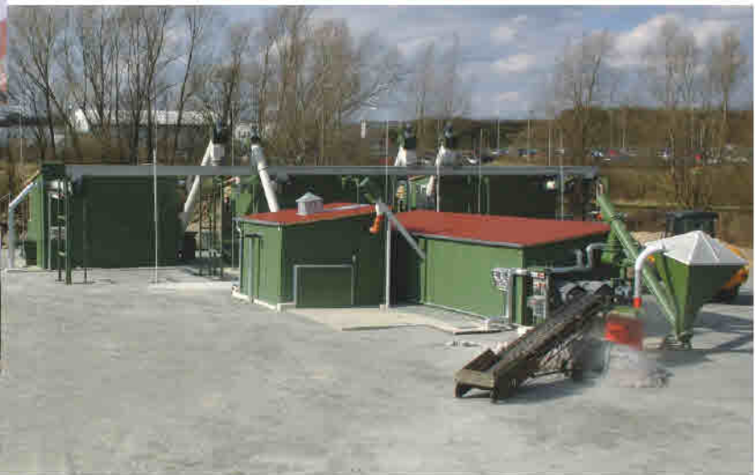
Das mineralit ® Betriebskraftwerk in Laage/Kronskamp (links: Bauphase)
