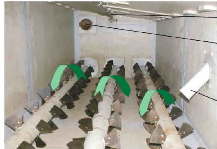
Blick in den leeren Mischbehälter; gegenläufige Drehrichtung der Paddelschnecken
