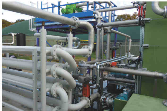
Ansicht Rohrbündelwärmetauscher
