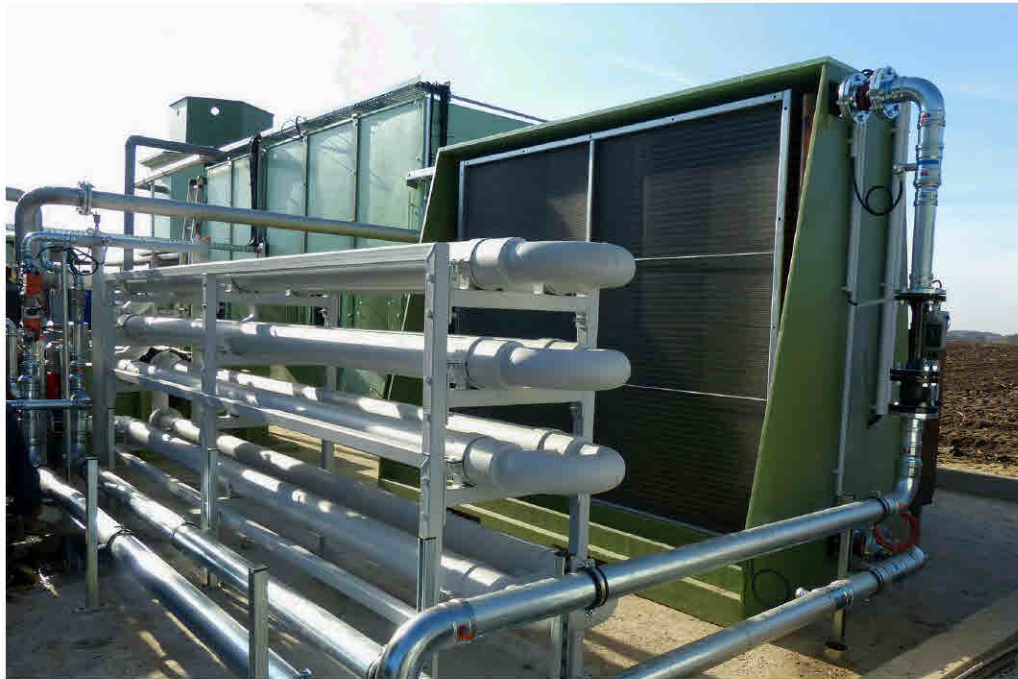
Ansicht Rohrbündelwärmetauscher
